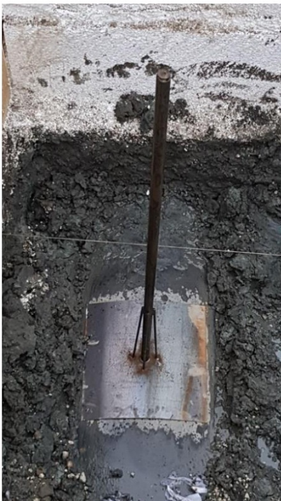
Impressie van een zakbaken op een buisleiding
