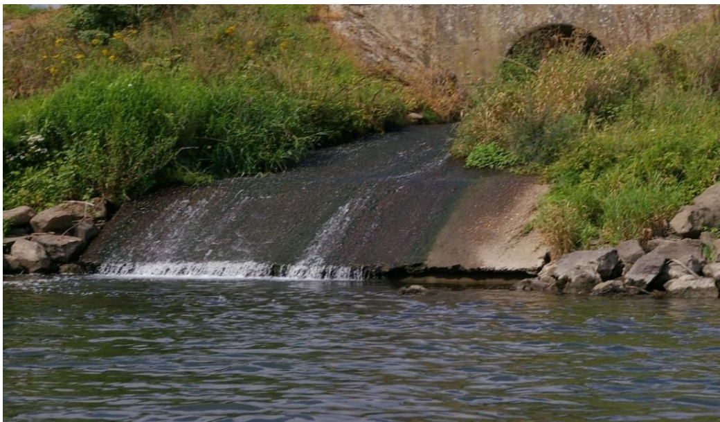
Figuur 5 Te verwijderen betonplaat bij de uitstroming van een beek in de Grensmaas
