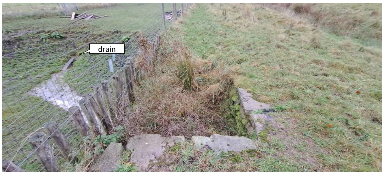
Figuur 2-5: Uitstroom van de drain van het laaggelegen perceel ten noorden van de beek, waarna water uit de drain een duiker in stroomt die uitkomt in de beek.
