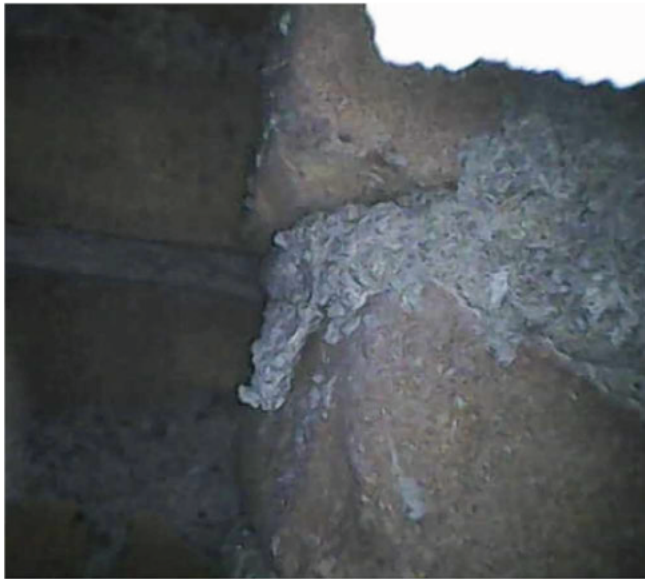
Opname met spouwcamera; Links zichtbaar het buitenblad, recht de neggekant die in 1 e instantie is gemeten.
