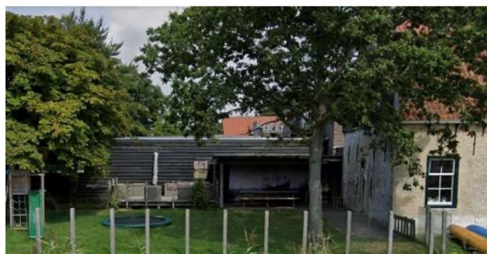
Bestaande situatie opslagruimte met plat dak
