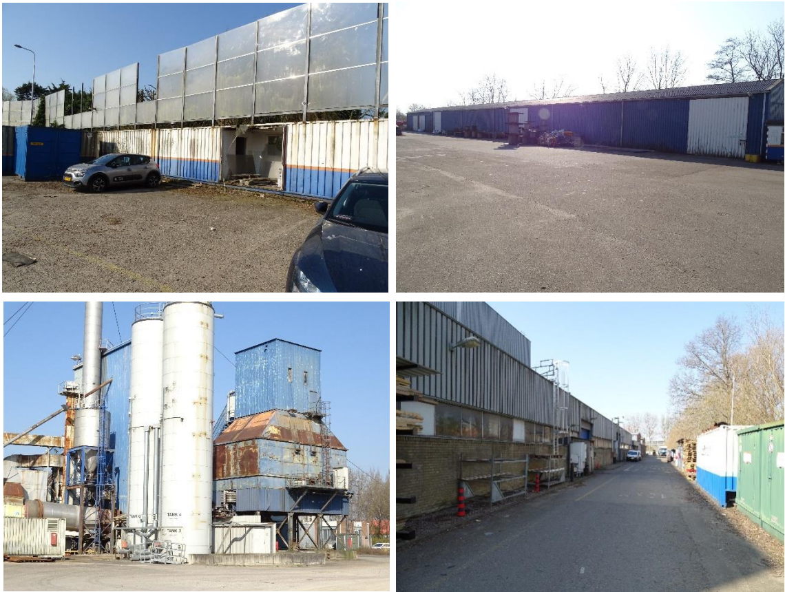
Afbeelding 2, Impressie van het noordelijke deel van het plangebied. Bovenste afbeelding laten containers en loodsen zien. Linksonder een afbeelding van de asfaltfabriek en rechtsonder de opslaggebouwen.
