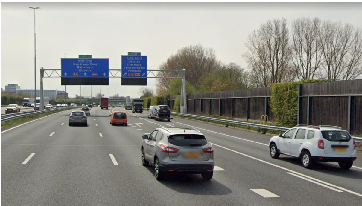
Foto: Langs rijksweg A4 is ter hoogte van het plangebied een houten geluidsscherm aanwezig van 3 meter hoog (bron: Google Streetview)
