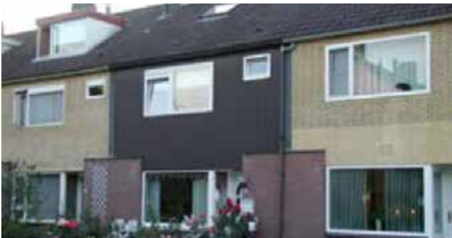
Afwijkend materiaalgebruik, maar waarbij de bestaande vormen van de gevelopeningen niet zijn veranderd
