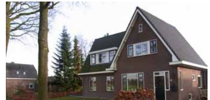
Aanbouw die in kleur- en materiaalgebruik en dakhelling goed aansluit
