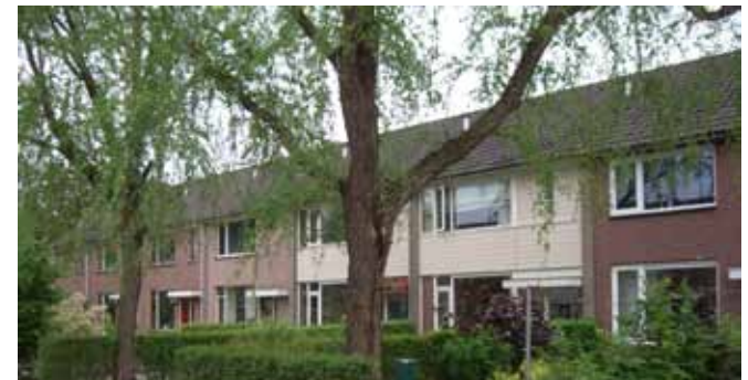
Afwijkend materiaalgebruik, maar waarbij de bestaande vormen van de gevelopeningen niet zijn veranderd
