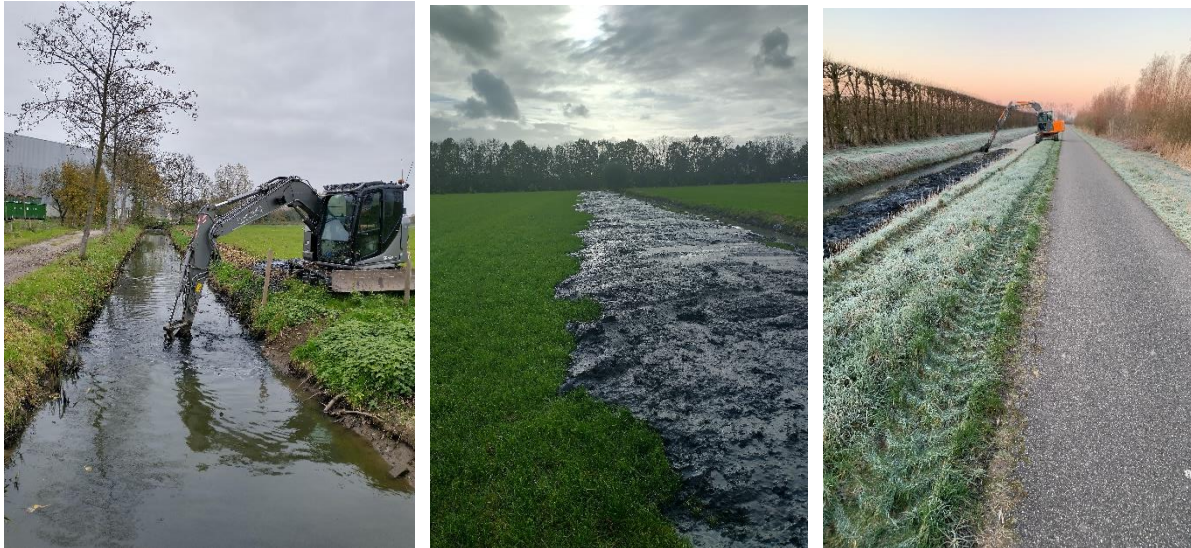
Foto's Uitvoering baggerwerkzaamheden in buitengebied
