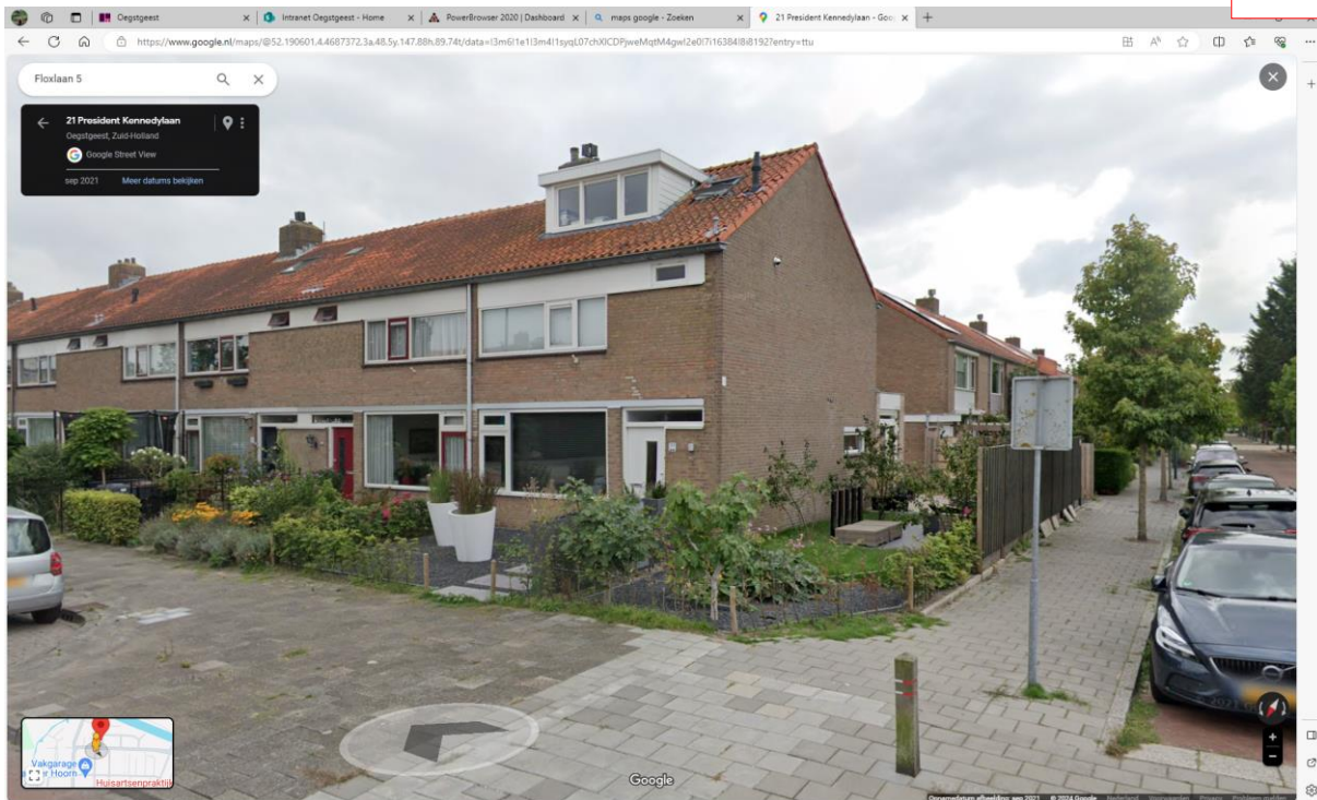
Dakkapel President Kennedylaan 22 – Dakkapel ruim onder nok geplaatst
