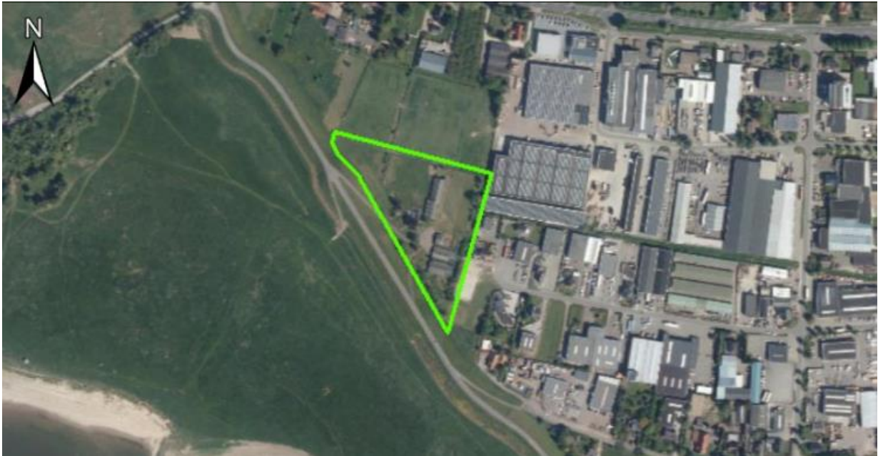
Afbeelding 2: Luchtfoto van het plangebied (bron: www.ruimtelijkeplannen.nl )
