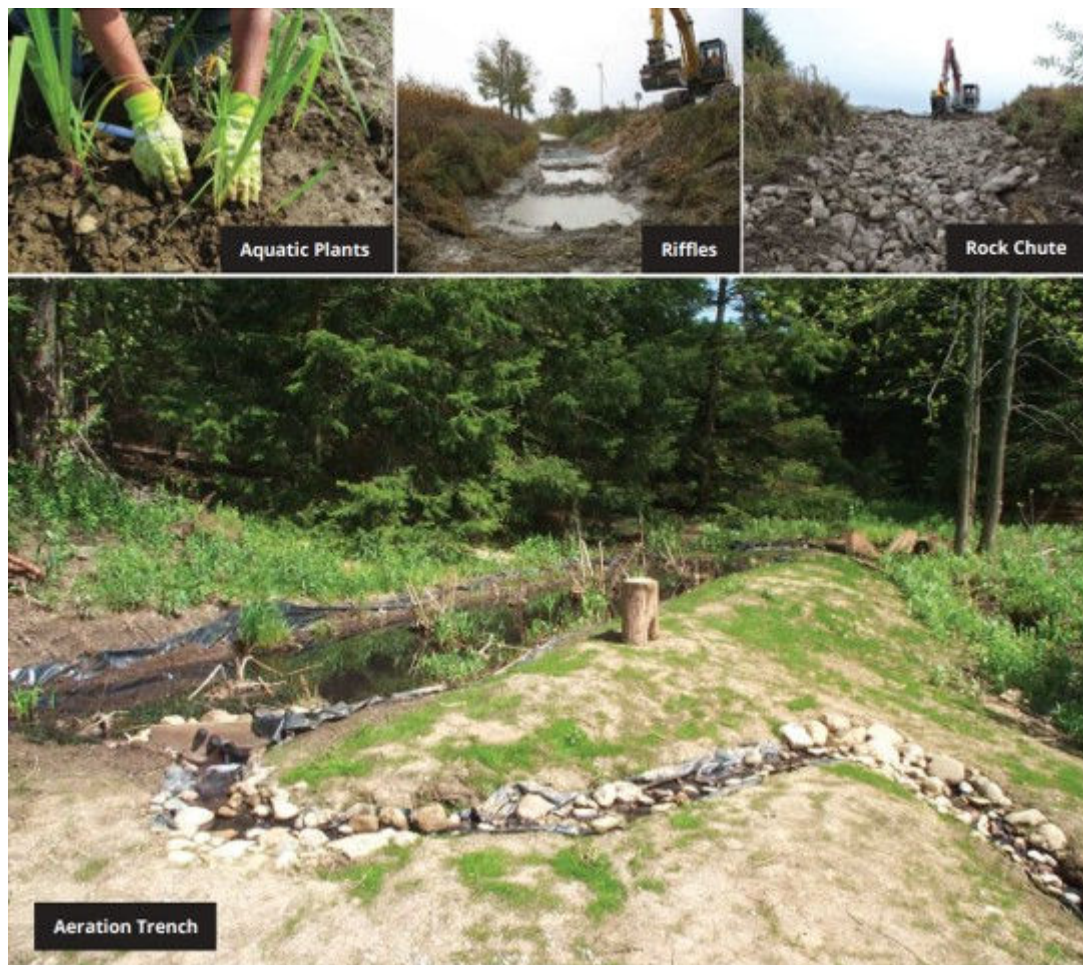
Figuur 4: Methoden om het effluent uit de bioreactor na te behandelen (Thames River, 2019)
