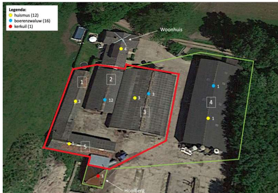
Figuur 2: Plangebied in rood met de aangetroffen verblijfplaatsen in geel (huismus) en blauw (boerenwaluw). Enkel de verblijfplaatsen binnen het rood omkaderde plangebied worden aangetast.
