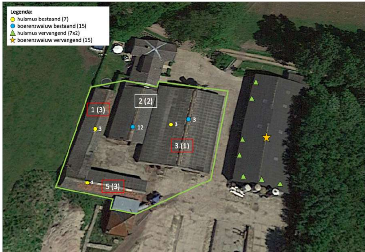
Figuur 1: Plangebied (groen begrensd). De te slopen schuren zijn genummerd, tussen haken is de nummering uit het asbestinventarisatie rapport vermeld. In de gebouwen 1, 3 en 5 is asbest aanwezig. N.B. de plaatsing van slechts 7 vervangende nestkasten voor huismus is beoordeeld als onvoldoende. De groene driehoeken kunnen in deze figuur genegeerd worden.
