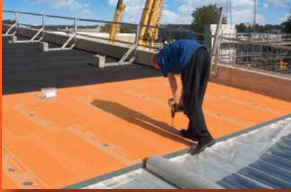
plat dak isolatie
