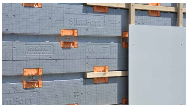
Afwerking met vezelcementplaten
