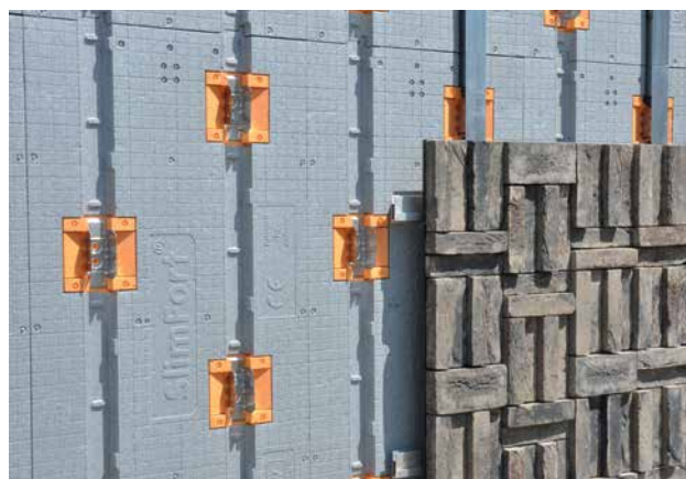
fischer draagsysteem met steenstripafwerking
