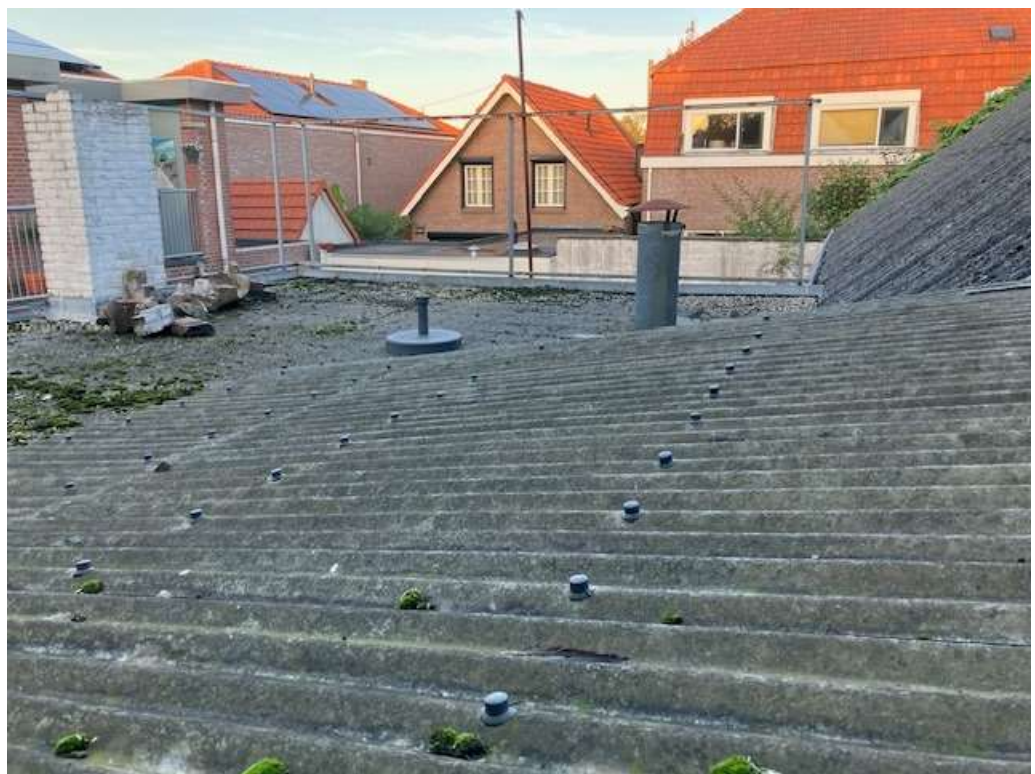
• Afbeelding 33: geschroefde asbest golfplaten boven platte aanbouw voormalige schuur
