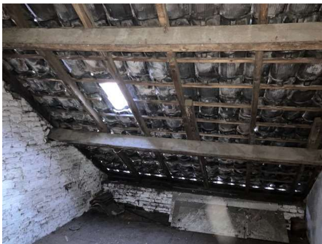
• Afbeelding 25: onderzijde dak voormalige schuur, ongeïsoleerd pannendak
