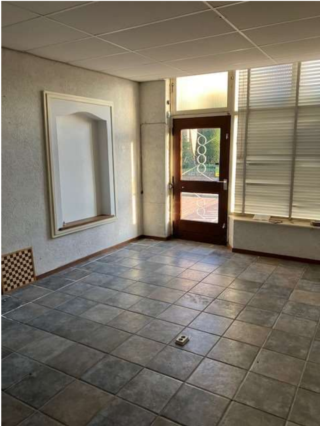
• Afbeelding 10: binnenzijde tussenbouw met deur van Kerkstraat 14a
