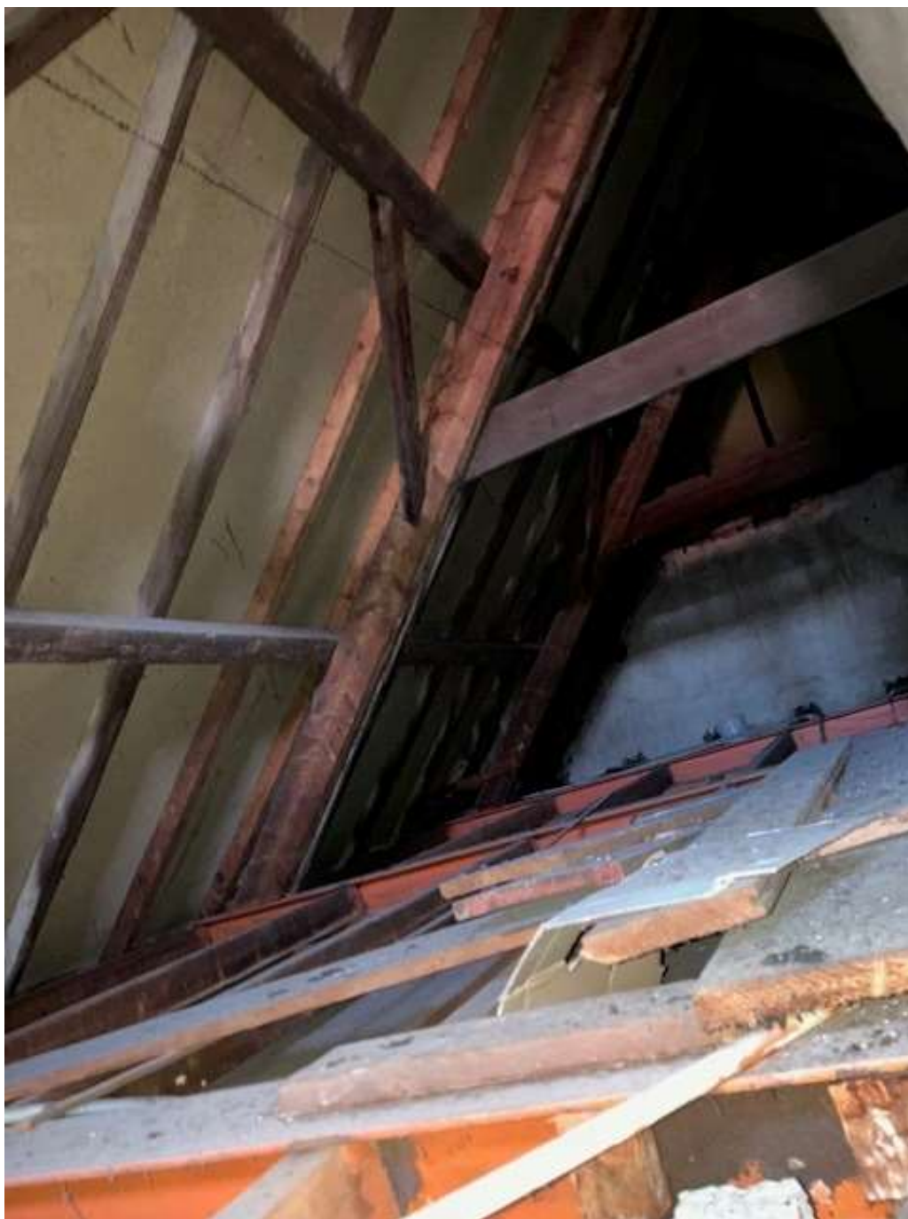
• Afbeelding 22: zolder boven hoofdgebouw, onderzijde dak met houten dakbeschoot
