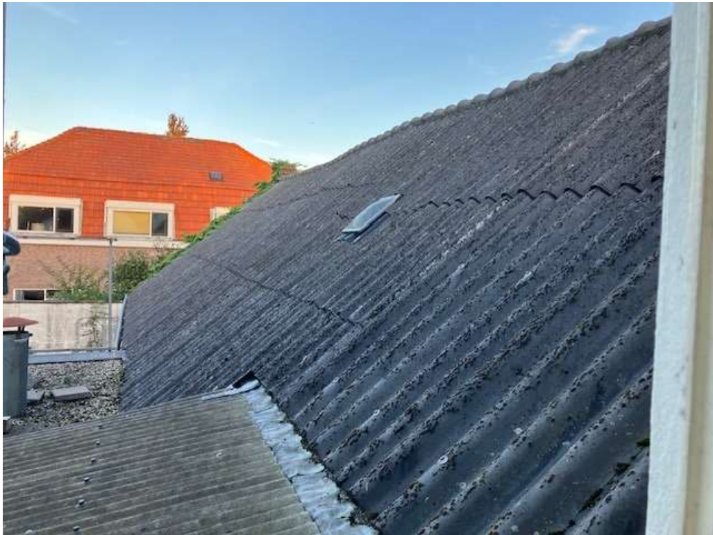
• Afbeelding 34: dak voormalige schuur met stalen golfplaten aan zijde binnenplaats
