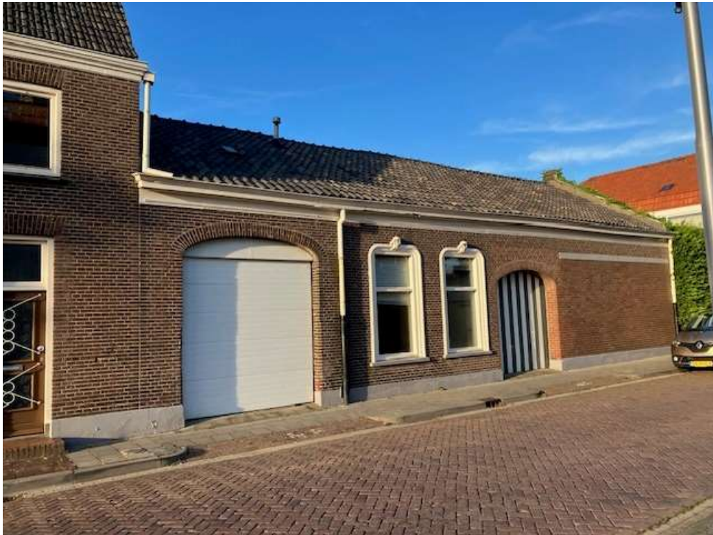
• Afbeelding 5: Voormalige schuur aan de Kerkstraat
