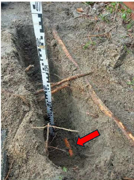
Proefsleuf 2, naast boom 99 met o.a. een laagspanningskabel (pijl).
