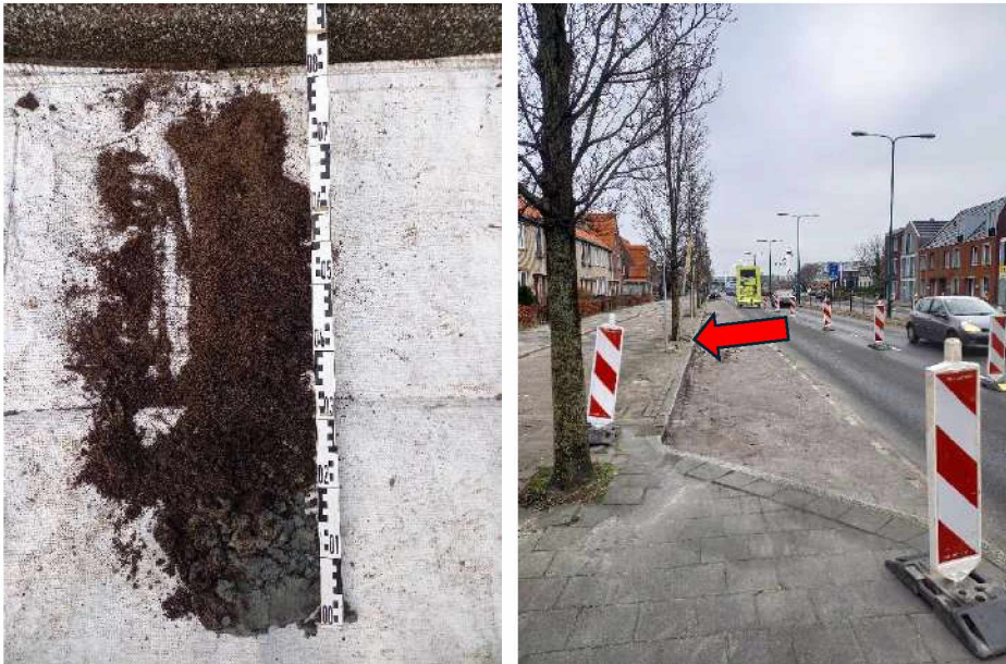
Boring 1, naast boom 29 (pijl).
