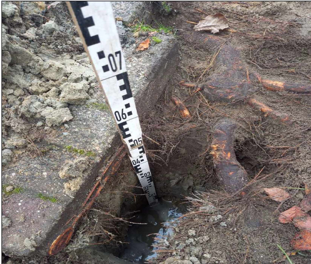
Foto 3: Impressie van de ontgraving op locatie A. oppervlakkig Beworteling op 100 cm vanuit het hart van de stam van boomnummer 37 Hierbij is het schijngrondwaterprofiel te zien op en 50 cm -mv.
