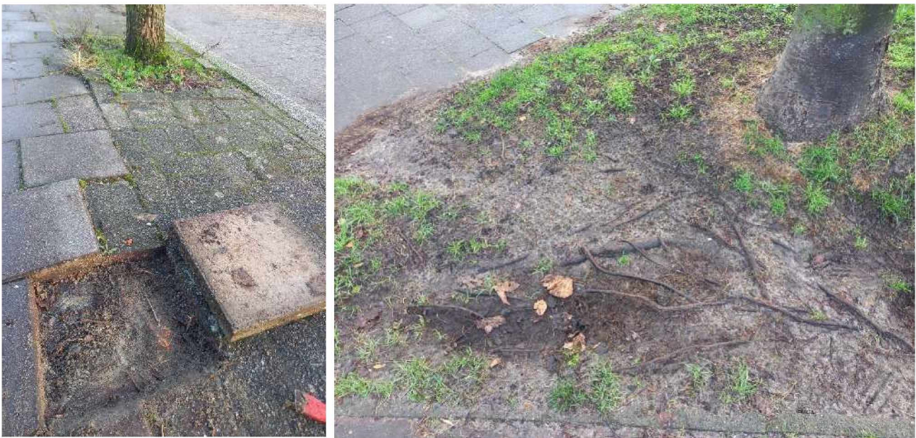
Diverse locaties met wortelopdruk en oppervlakkige beworteling (hier door 'olifantenpaadje' van voetgangers).
