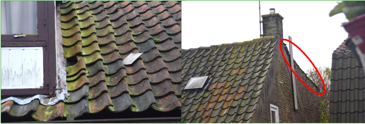
Een weggeschoven dakpan op het dak van Doctor van Noortstraat 112 en 114.
