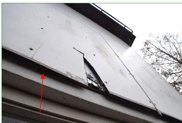
Doctor van Noortstraat 122 en 122a. Achter de kunststofplaten zitten grote kieren..
