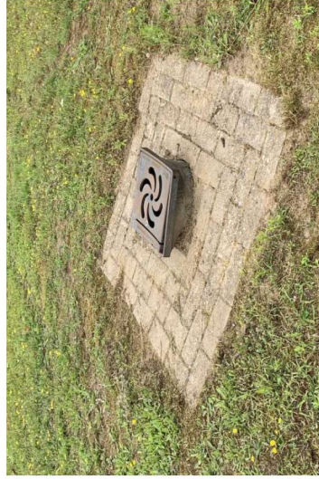
Voorbeeldreferentie van een slokop, precieze inpassing van de te nemen maatregelen volgen in de uitwerking.
