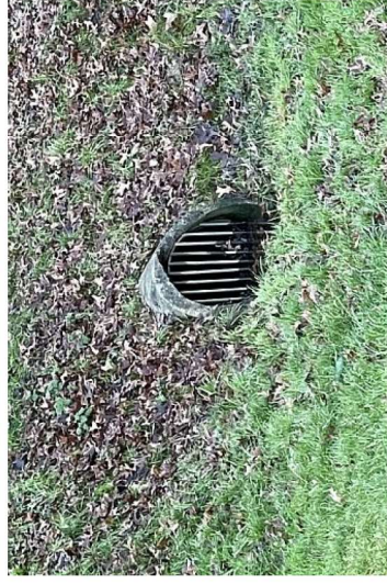
Voorbeeldreferentie van een uitstroompip, precieze inpassing van de te nemen maatregelen volgen in de uitwerking.
