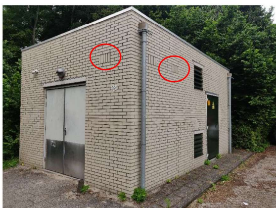
Figuur 5.1 De locaties van de openstootvoegen. Boven: Enkele ramen waarboven openstootvoegen aanwezig zijn. Linksonder: De openstootvoegen op de elektriciteitscabine (rood omcirkeld). Rechtsonder: De rij van vijf openstootvoegen boven een raam (rood omcirkeld).
