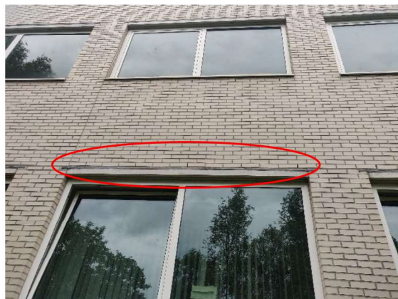
Figuur 5.1 De locaties van de openstootvoegen. Boven: Enkele ramen waarboven openstootvoegen aanwezig zijn. Linksonder: De openstootvoegen op de elektriciteitscabine (rood omcirkeld). Rechtsonder: De rij van vijf openstootvoegen boven een raam (rood omcirkeld).
