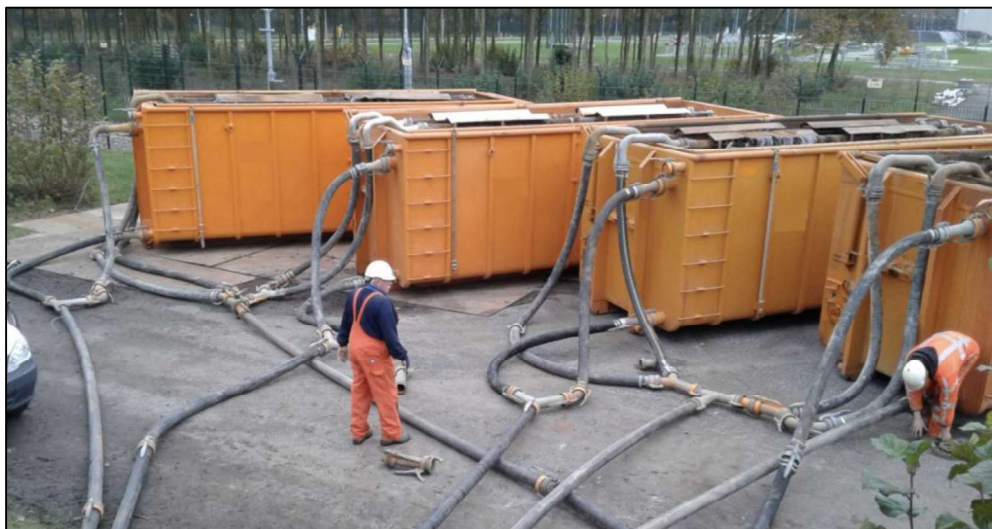
Figuur 10 – Meerdere strofilters
