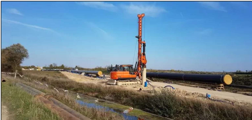
Figuur 9 – Aanbrengen deepwells (de boorstelling als voorbeeld)
