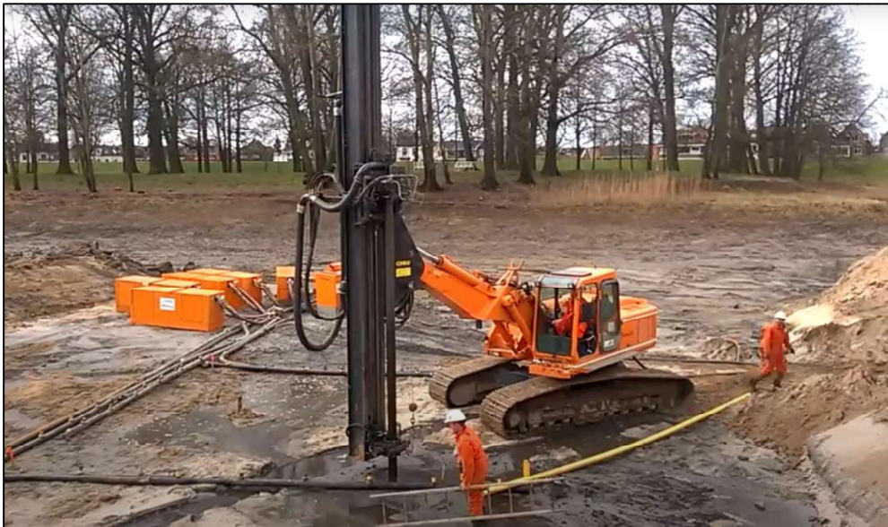
Figuur 8 – Aanbrengen verticale filterbemaling
