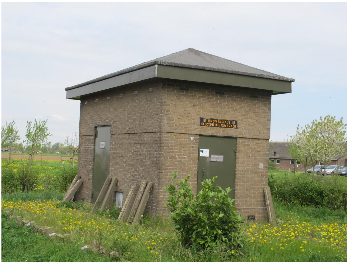
Figuur 130. Transformatorhuisje uit het interbellum aan de Zeelandsestraat in Millingen aan de Rijn (foto: MAB, 2014).
