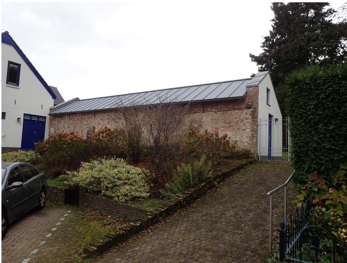
Figuur 53. Oud muurrelict van de buitenplaats, aan de noordwestzijde (foto: RAAP, 7 november 2022).
