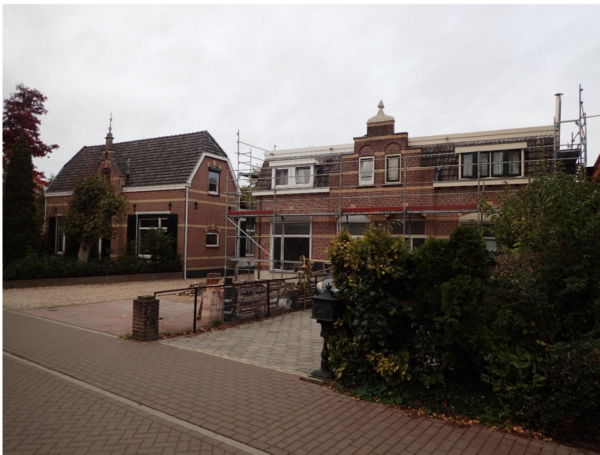
Figuur 113. De oude marechausseekazerne in Groesbeek, aan het Binnenveld (links) (foto: RAAP, 7 november 2022).
