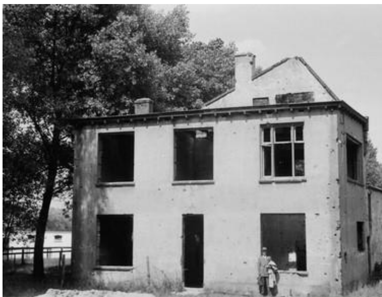
Figuur 107. Restanten van de oude botenfabriek in Wyler, vanuit het zuiden (bron: roeimuseum.nl). De hoge muur met schoorsteen heeft een gespiegelde vorm ten opzichte van de foto's hiervoor: de foto van de gebouwuïne is dus waarschijnlijk vanaf de straatwegzijde gemaakt.
