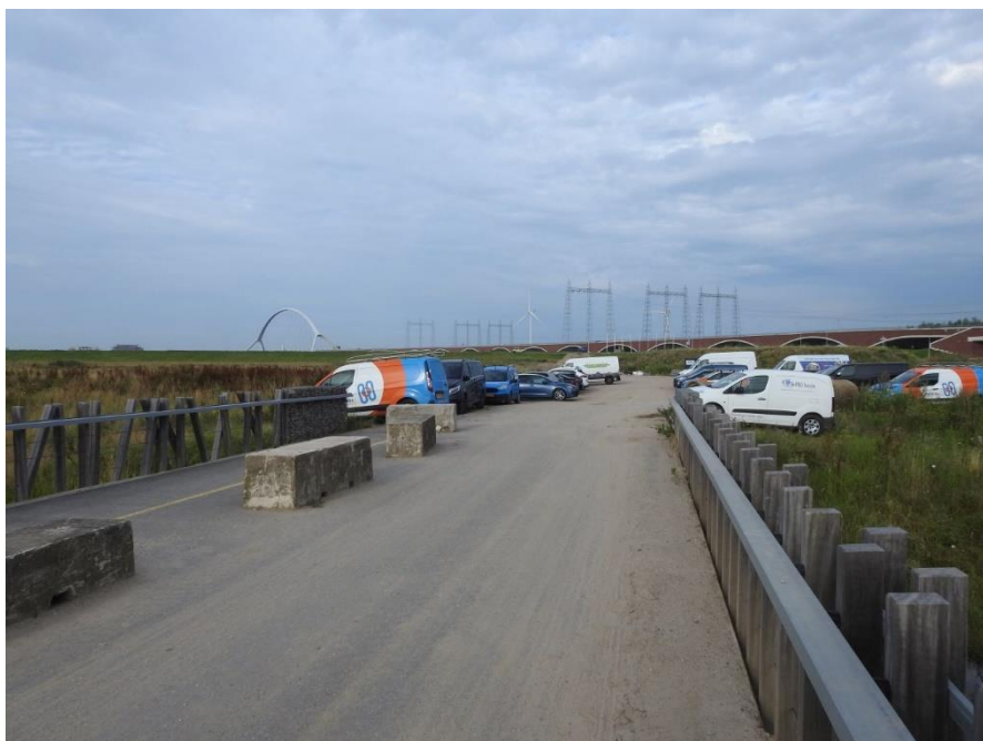
Tijdelijke brug naar parkeerplaats in het projectgebied.
