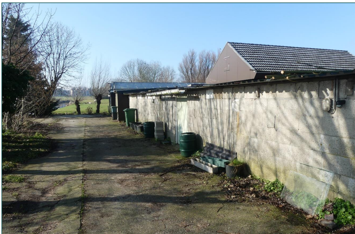
Figuur 3 In de beoogde ontwikkeling wordt de bergingsruimte, welke is opgebouwd uit betonblokken met een golfplaten dak, eveneens gesloopt.
