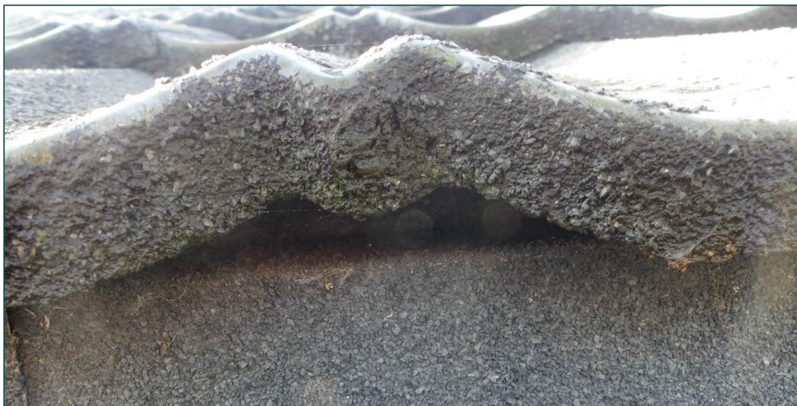
Figuur 3.2 De openingen onder de dakpannen zijn voor de huismus te smal om vanuit de dakgoot te kunnen betreden.
