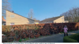
Beperkte zichtbaarheid kruispunt nieuwbouw school
