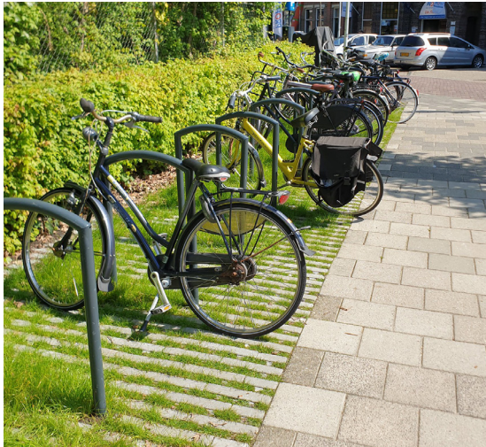
Fietsparkeren op (half)open verharding
