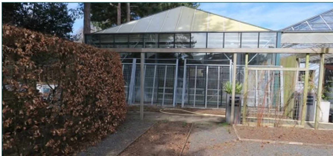
Figuur 3.1 De te slopen kassen bestaan voornamelijk uit glas, zonder toegankelijke spouw of dakruimte.
