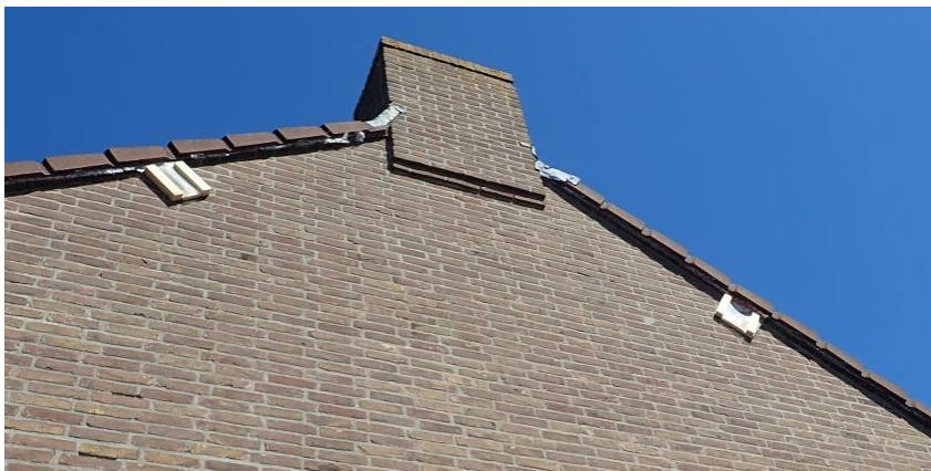
Afbeelding 10: "Exclusion flap" in een met spouwborstels afgedichte kopgevel
