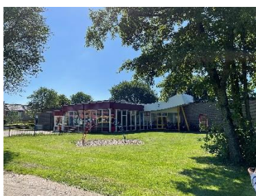
Bestaande basisschool Yn de Mande
