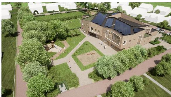
Het nieuwe gebouw ligt vrij op de kavel omgeven door groen. De bestaande gymzaal gaat op in de vormgeving van het gebouw.
