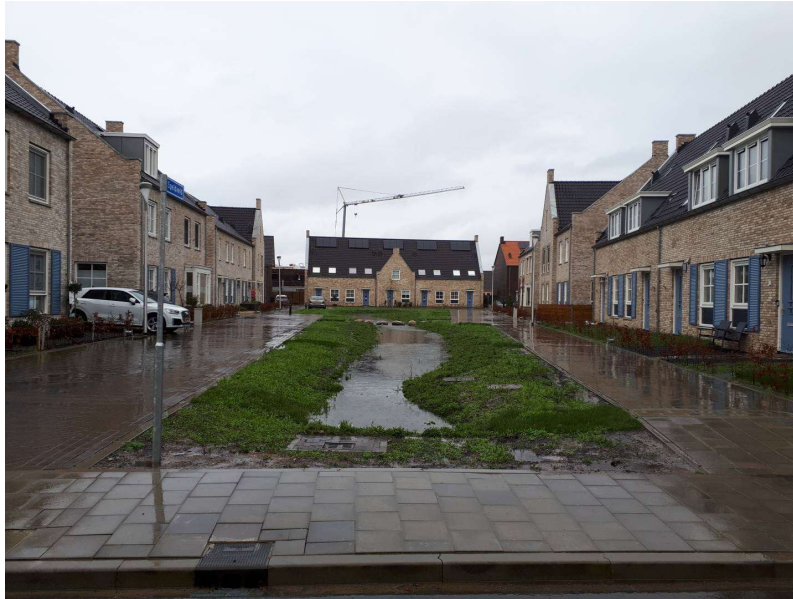
Figuur 13: Oppervlakkige waterberging in wadi aan de Speltveld in Beneden Leeuwen.
