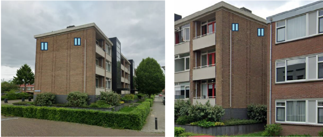
Afbeelding 8: De locaties van de ingemetselde permanente zomerverblijven. Elk verblijf bestaat uit twee gekoppelde kasten.
