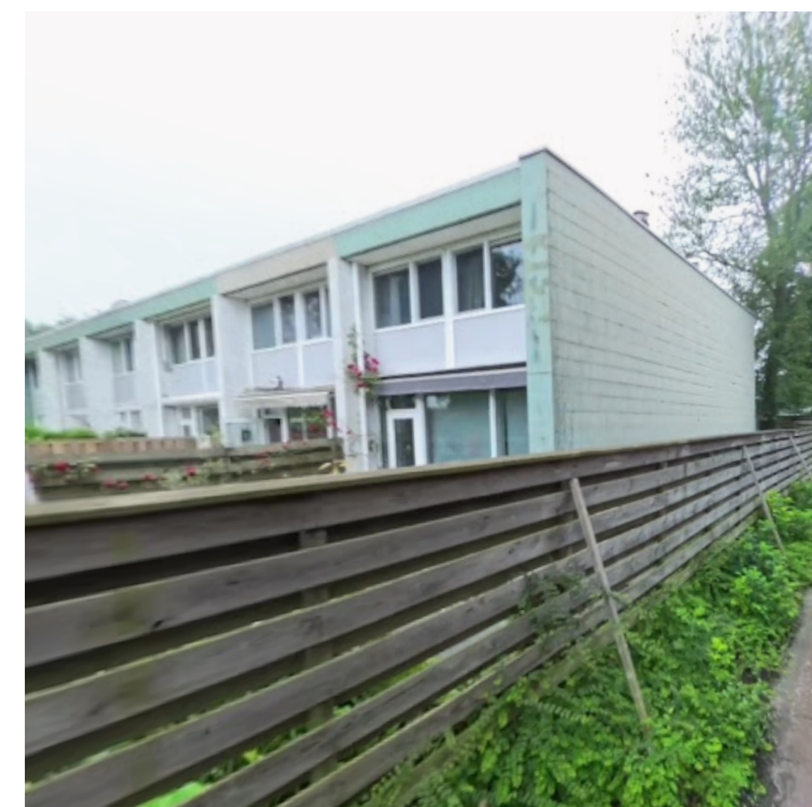
foto bestaande situatie achtergevel
