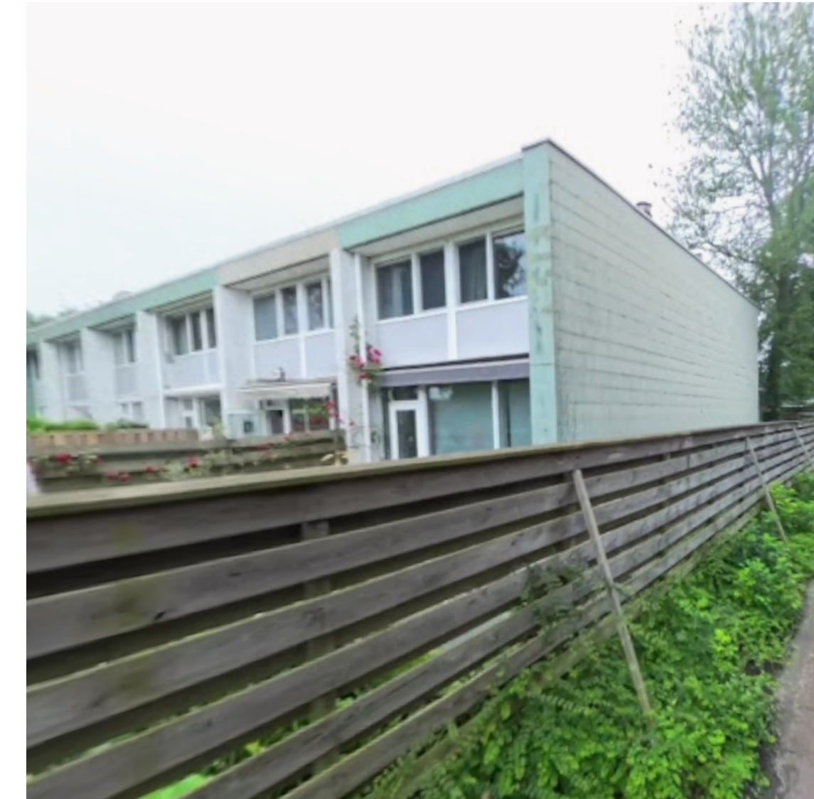
foto bestaande situatie achtergevel
