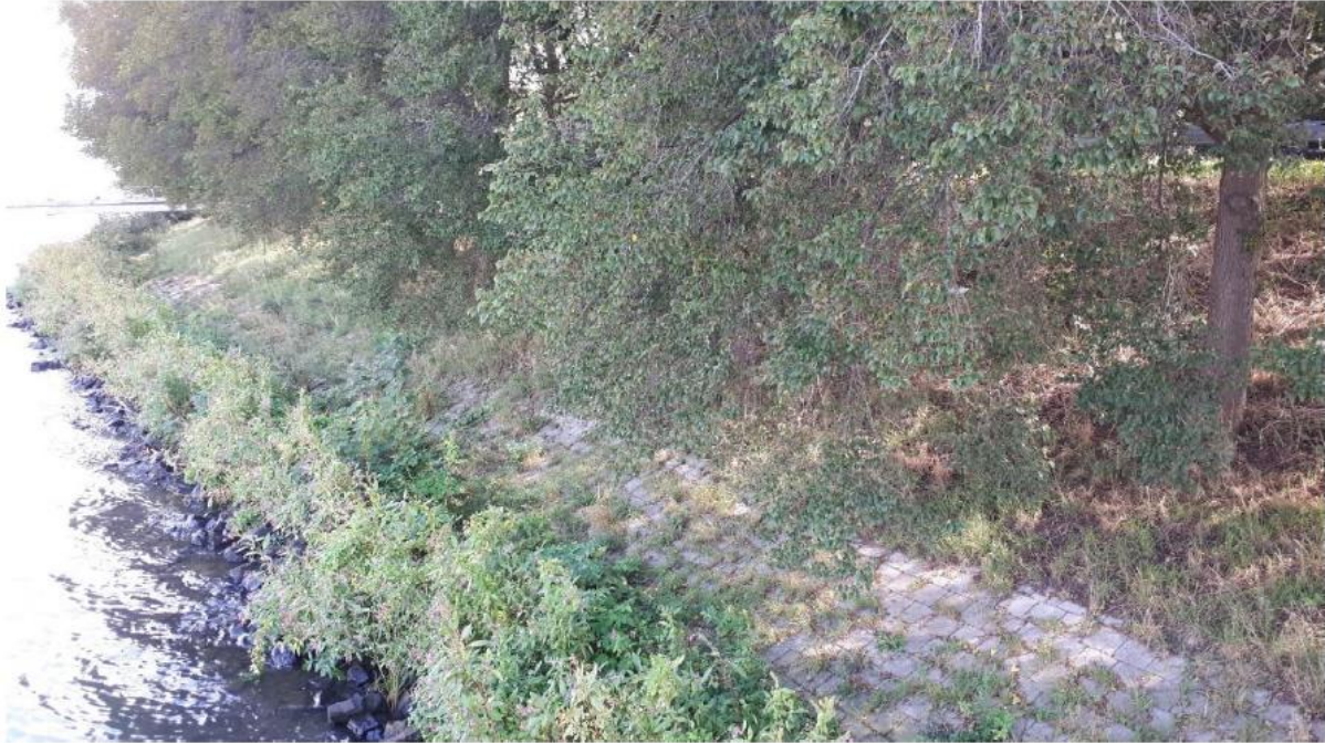
Figuur 2.2 Zetsteen bij het deeltraject Volkeraksluizen-Willemstad
