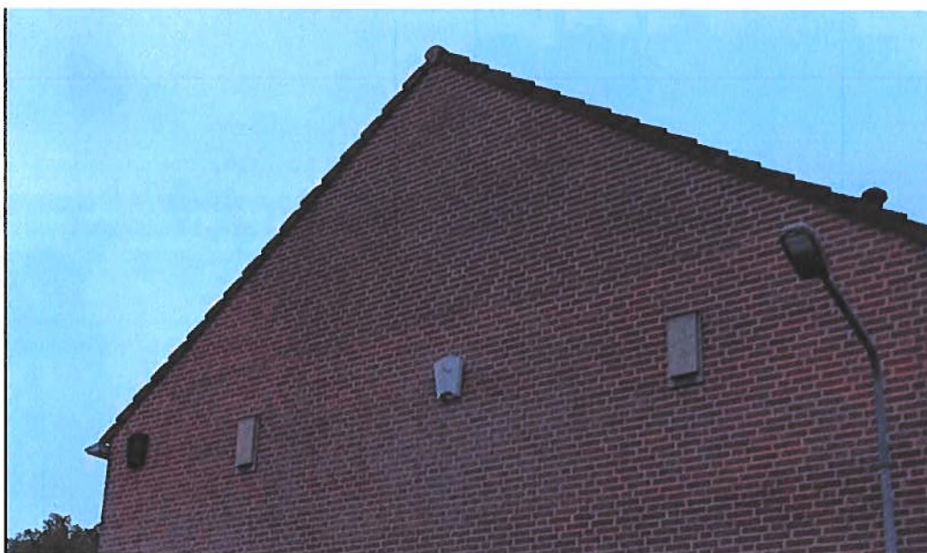
Figuur 6. Locaties tijdelijke alternatieve verblijfplaatsen in de vorm van vier vleermuiskasten aan de gevel van de Liebergerweg 710.
