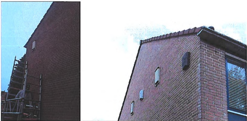
Figuur 4. Locaties tijdelijke alternatieve verblijfplaatsen in de vorm van vijf vleermuiskasten aan de gevel van de Liebergerweg 700.
