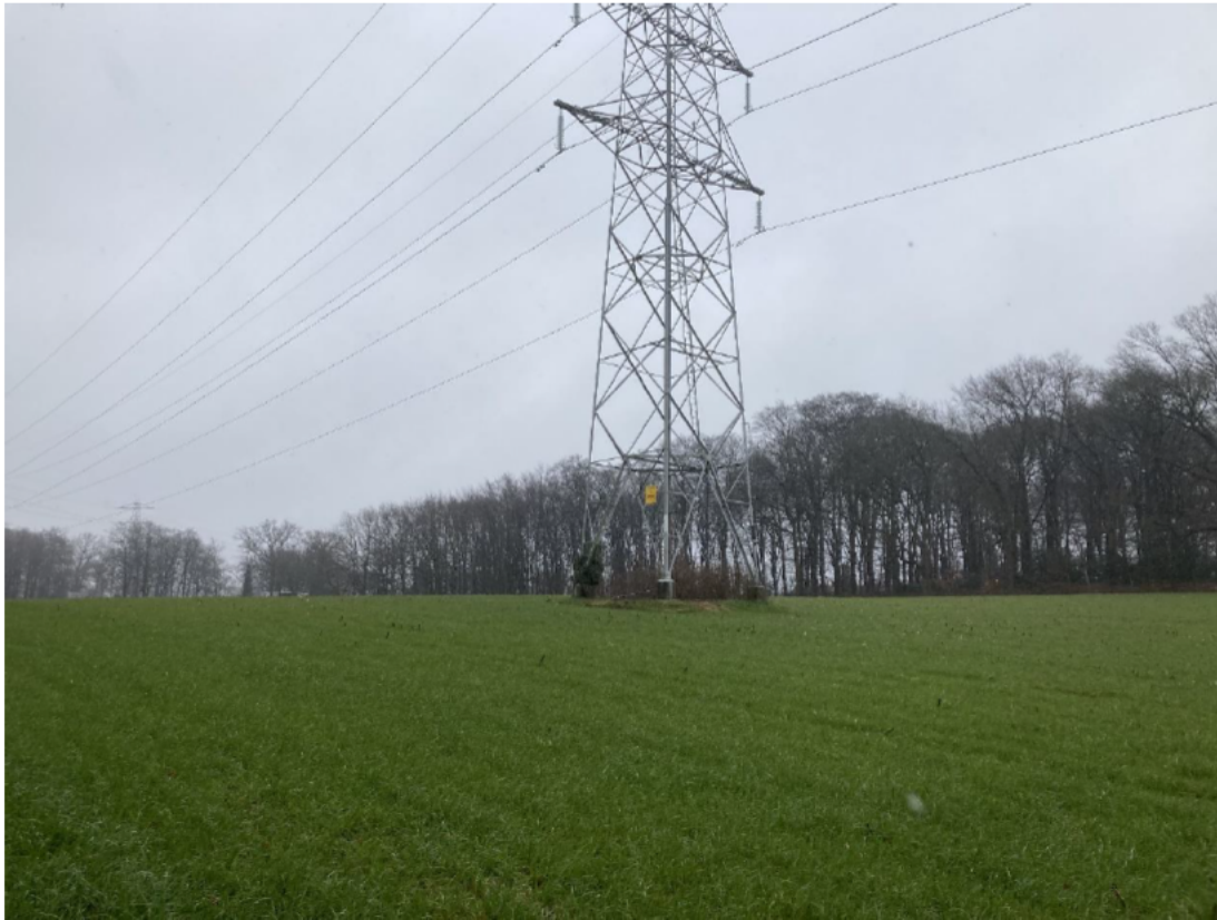
Figuur 1.2. Overzicht mast 60, gezien vanuit het zuidwesten.
