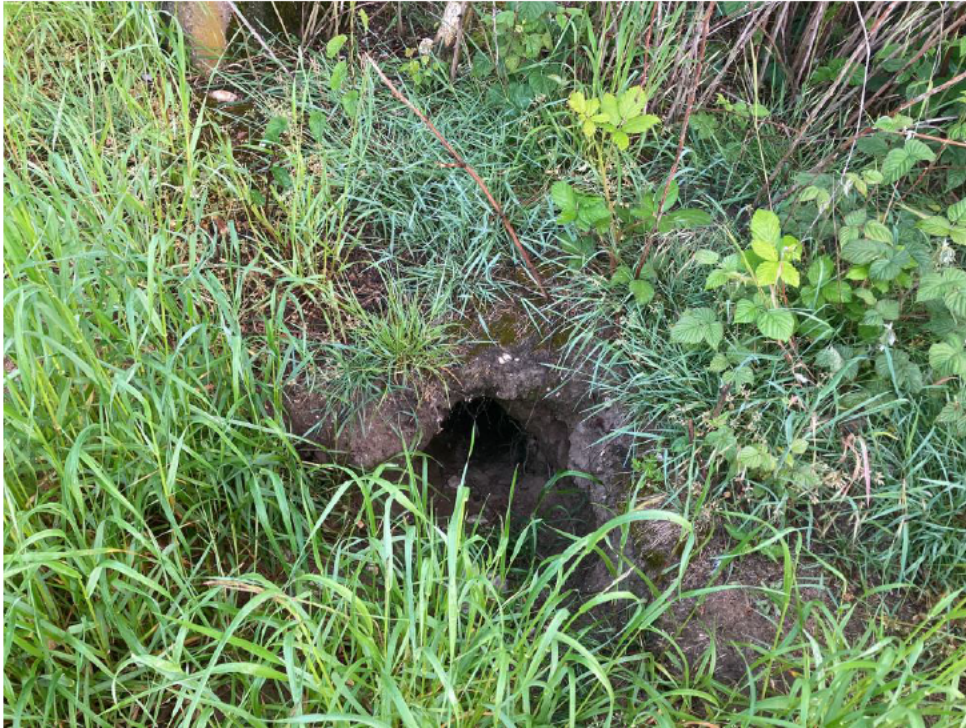
Figuur 3.3. Vluchtpijp direct naast de betonpoer.
