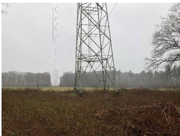
Figuur 1.18. Overzicht plangebied mast 68, gezien vanuit het oosten.
