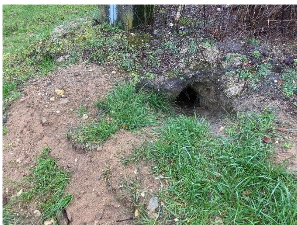
Figuur 3.7. Recente vluchtpijp bij mast 60, te zien aan verse zandwaaier.
