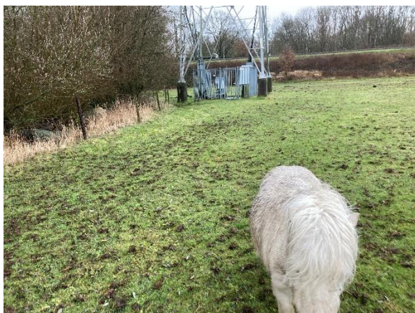
3.25. Mast 55 gelegen op weideperceel.
