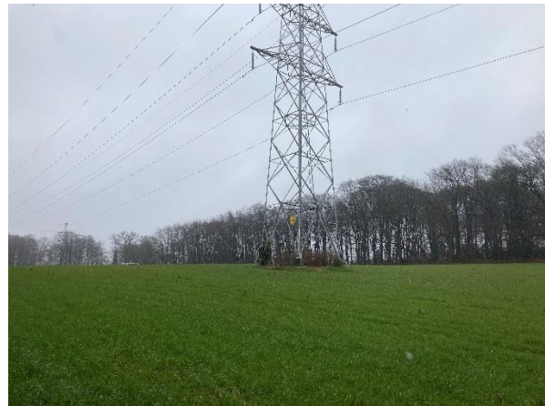
Figuur 1.15. Overzicht plangebied mast 60, gezien vanuit het zuidwesten.
