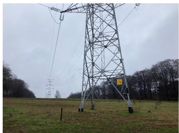
Figuur 1.13. Overzicht plangebied mast 58, gezien vanuit het zuidwesten.
