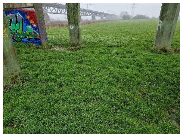
Figuur 1.5. Overzicht plangebied mast 50, gezien vanuit het noorden.
