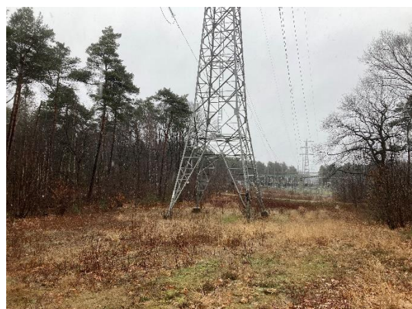
Figuur 1.19. Overzicht plangebied mast 69, gezien vanuit het zuidwesten.
