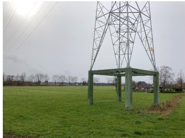
Figuur 1.3. Overzicht plangebied mast 48, gezien vanuit het oosten.
