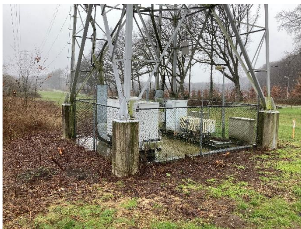
Figuur 1.16. Overzicht plangebied mast 64, gezien vanuit het oosten.
