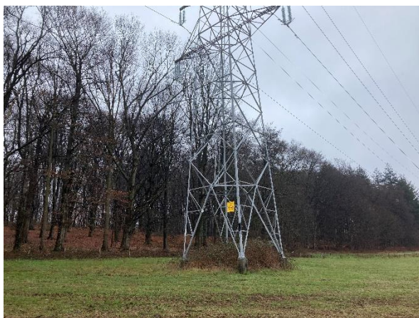
Figuur 1.12. Overzicht plangebied mast 57, gezien vanuit het zuidwesten.
