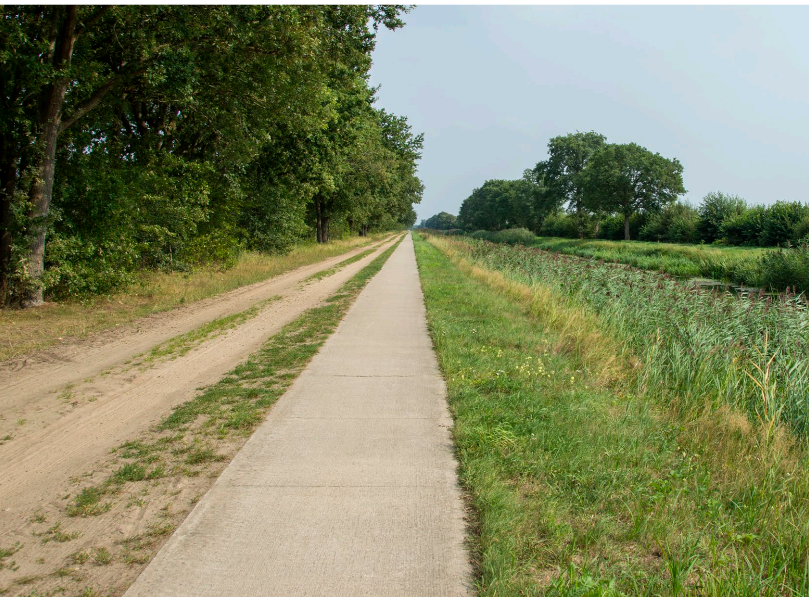
Afbeelding 1. Fietspad ten noorden van het Overijsselsch kanaal, aan de rechterzijde van het kanaal ligt het plangebied.
