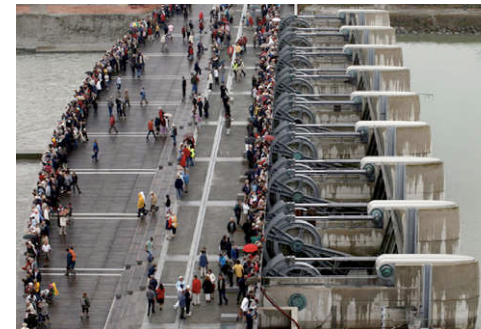
Referentiebeeld doorlaatwerk Le Mont Saint Michel: ontwerp en techniek geïntegreerd, asymmetrisch profiel benadrukt de werking
