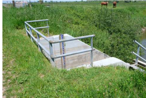
Betonnen wanden volgen talud
