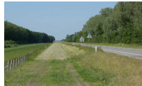
Bestaande situatie Drontermeerdijk
