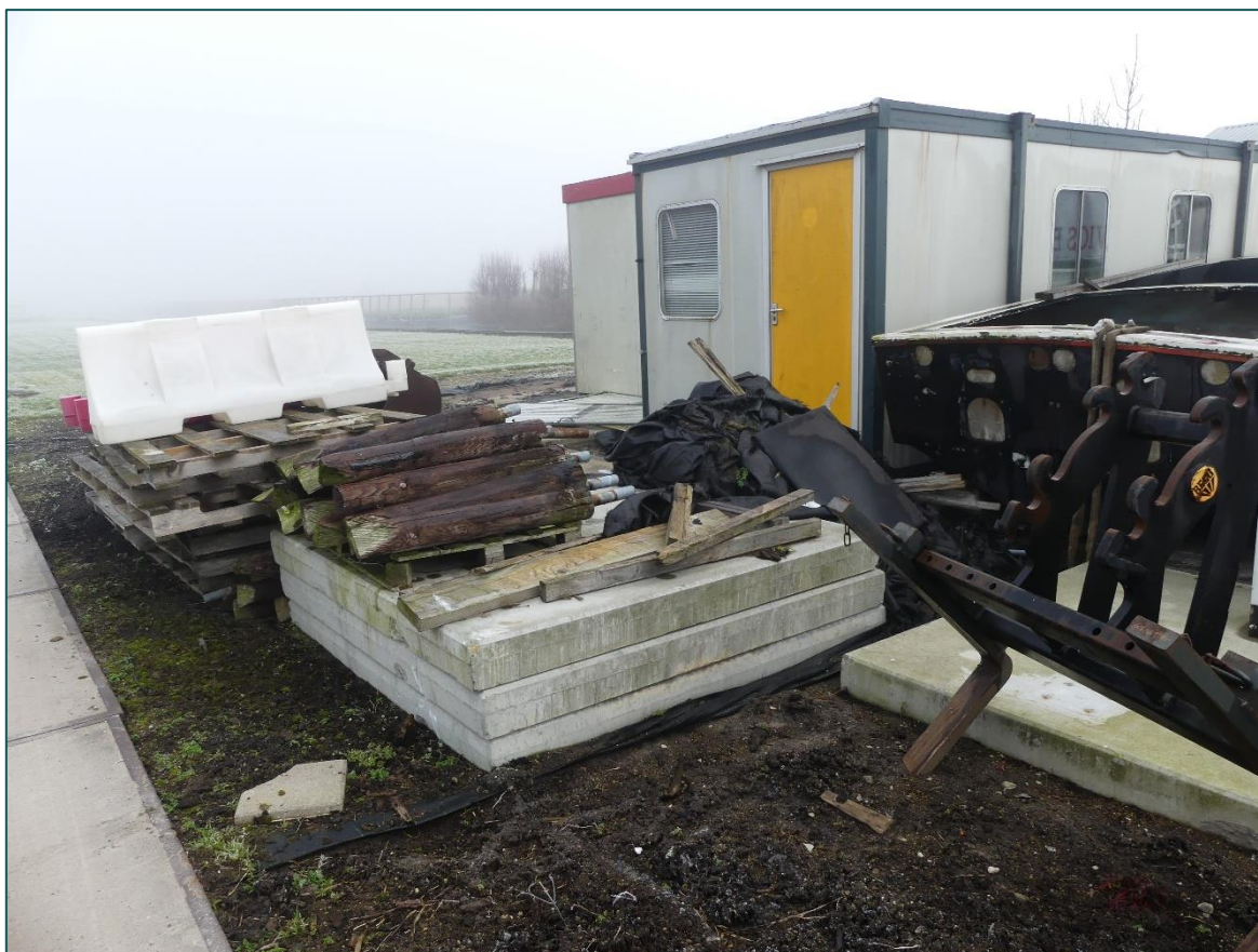
Figuur 3 De planlocatie fungeert in de huidige situatie als opslag van materialen en er staat een aantal containers.
