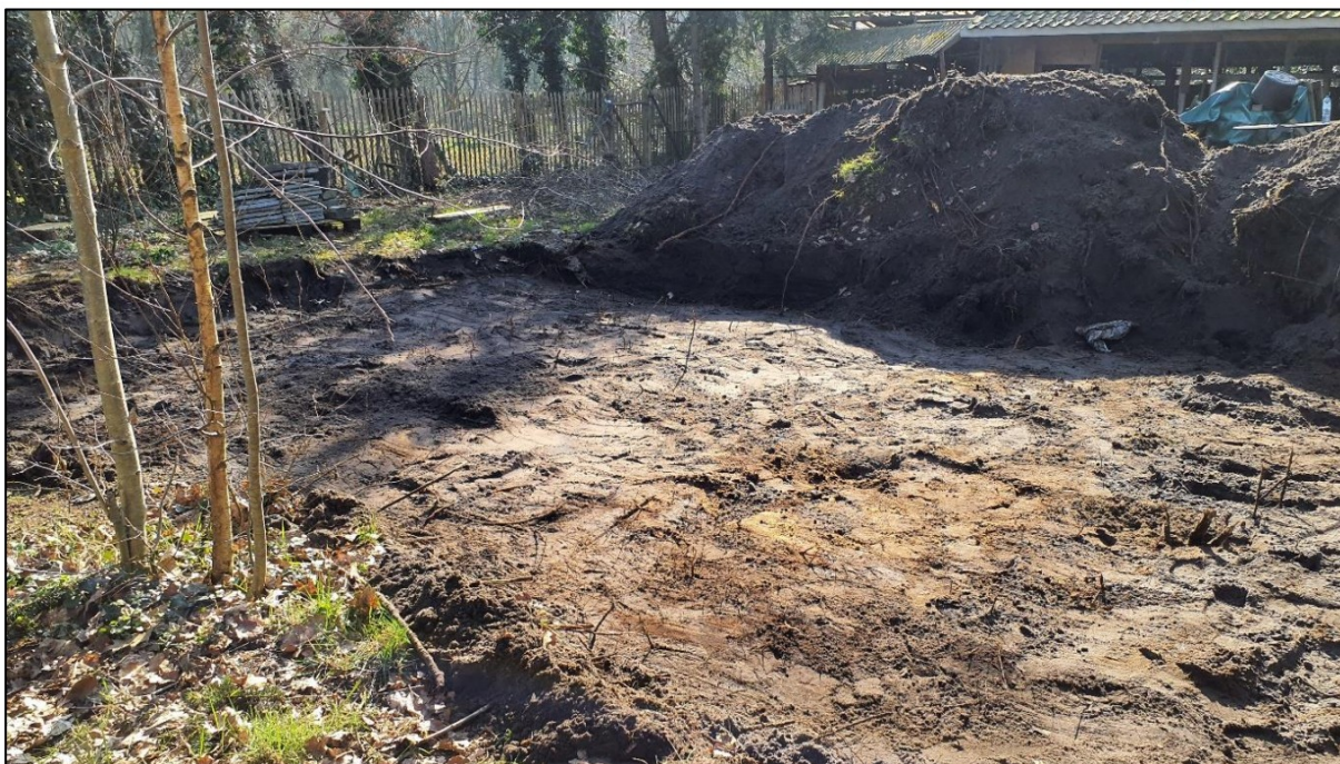
Afb.1 – Ontgraven van de bovenste laag van het opsporingsgebied
