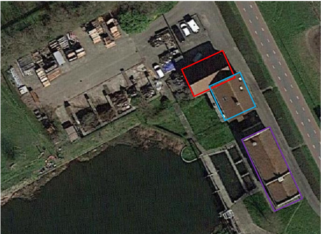
Afbeelding 1.2. Luchtfoto van een deel van het plangebied. Het huidige gemaal inclusief transformator gebouw is aangegeven met een paarse lijn, de huidige woning/voormalig stoomgemaal is aangegeven met een blauwe lijn, en de schuur is aangegeven met een rode lijn.
