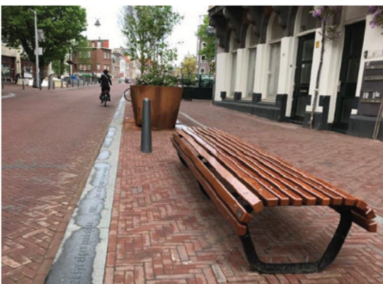
Referentiebeeld betonnen band ter markering oversteekplaats Bandijk. In combinatie met gebakken elementenverharding zorgt dit voor een fraai beeld.
