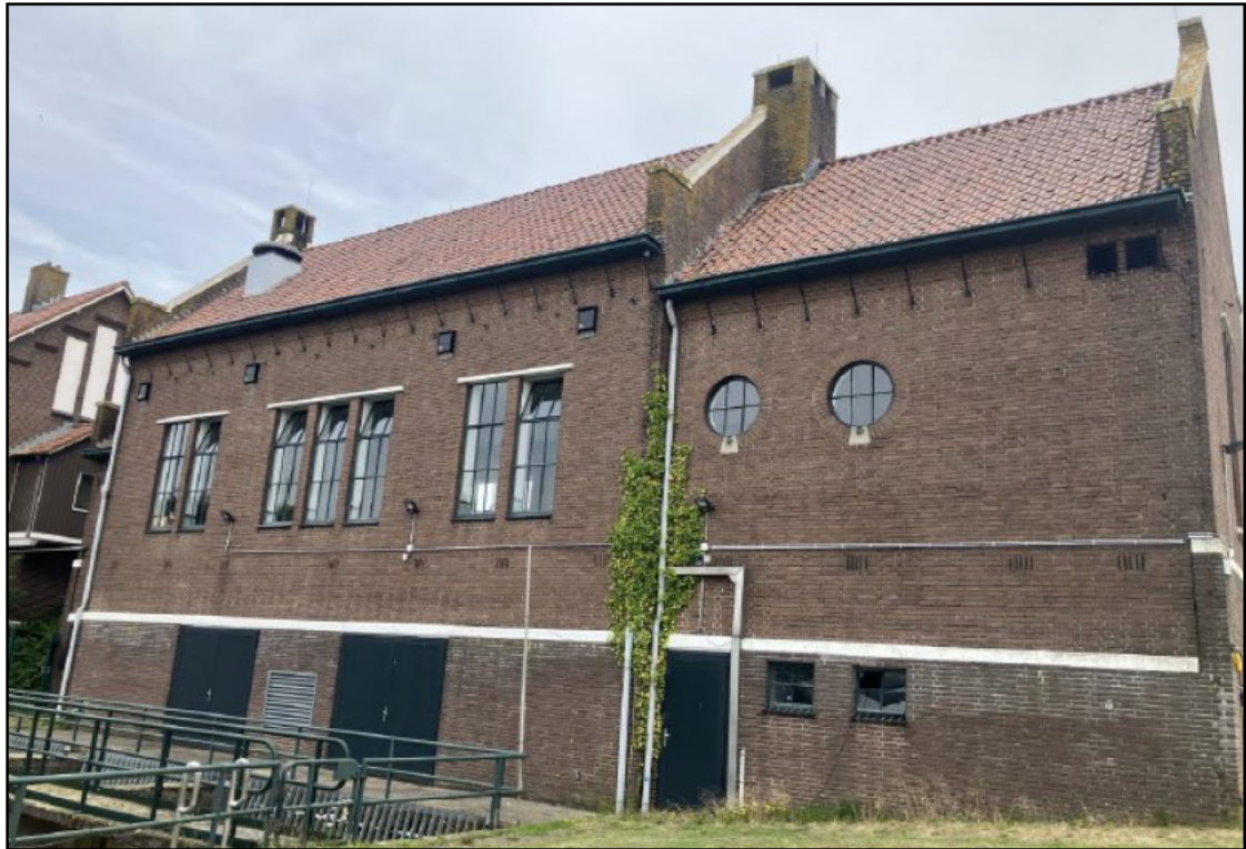
Afbeelding 5: De vier geplaatste tijdelijke vleermuiskasten aan gebouw 1.
