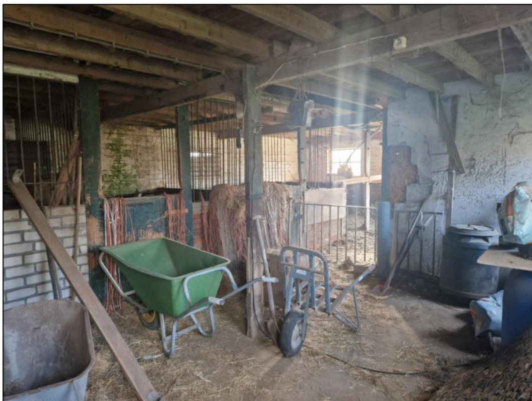
Figuur 3. Deel van de schuur met zolder dat wordt gebruikt als geitenstal.
