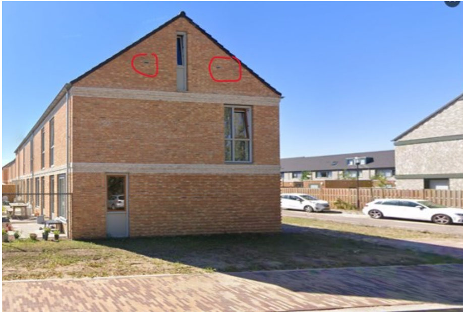
Figuur 2: Plaatsing inmetselekasten in gevels nieuwbouwwijk Zuiderveld
