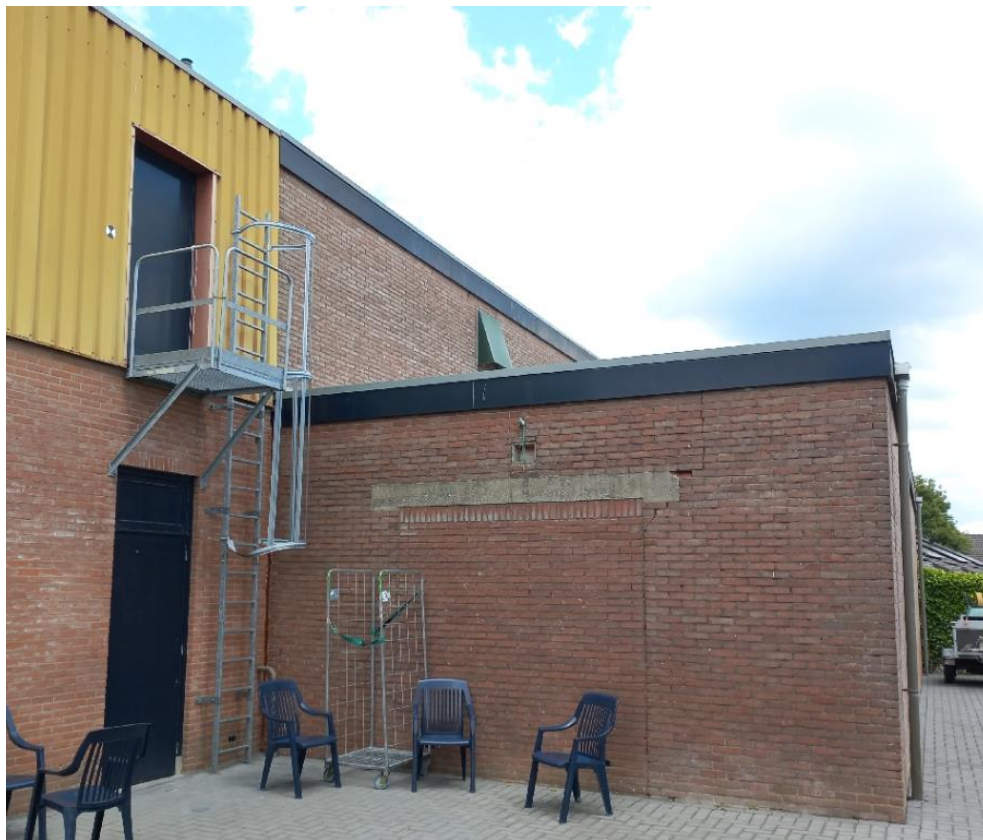
Het te verwijderen lager gelegen gebouw en de dakrand aan het te behouden gebouw.
