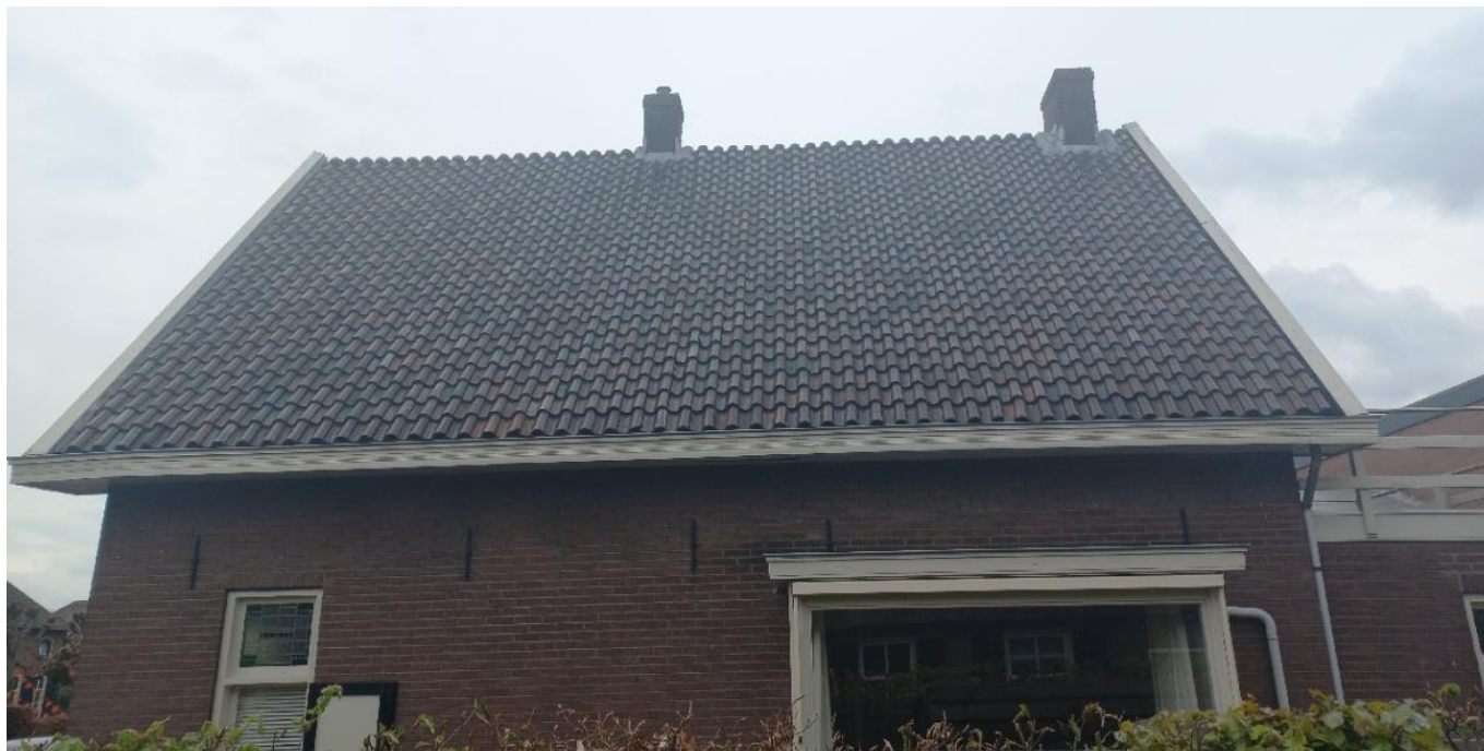
De voor nesten van huismussen geschikte dakrand van het woonhuis.
