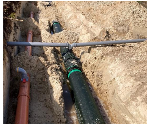
Figuur 2-1 Aanleg riolering in Eemnes
