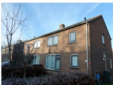
Figuur 2.10 Aanzicht en kopgevel van een van de woonblokken aan de Ploegstraat te Zetten.
