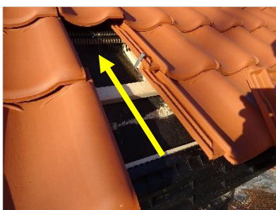
Figuur 6.7 Voorbeeld plaatsen vogelschroot bij derde rij dakpannen.
