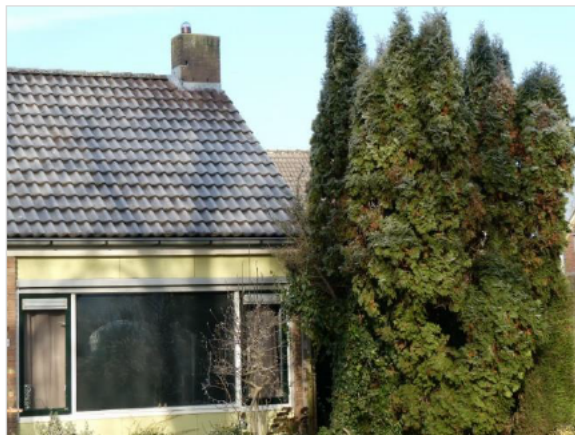
Figuur 5.2 Begroeiing direct naast de gevel van woningen aan de Hoofdstraat te Herveld.
