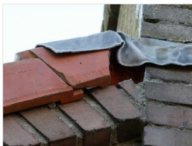
Figuur 5.13 Ruimtes onder de dakpannen en loodslabben van de woningen aan de Hessenbergstraat te Zetten.
