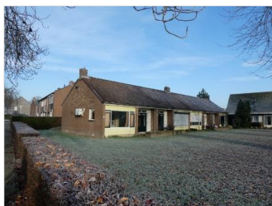
Figuur 2.5 Overzicht van de woningen aan de Hoofdstraat te Herveld.
