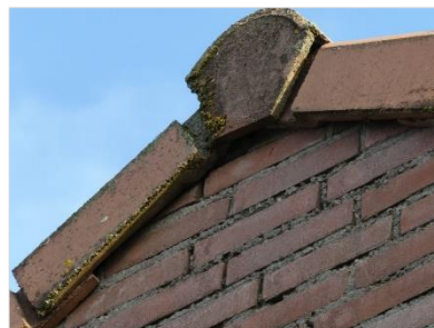
Figuur 5.9 Eindvorst met opening van een woning aan de Ploegstraat te Zetten.
