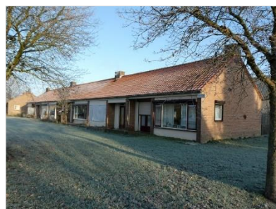
Figuur 2.7 Voorzijde van de woningen aan de Hessenbergstraat te Zetten.
