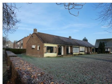
Figuur 2.11 Achterzijde van de woningen aan de Hessenbergstraat te Zetten.
