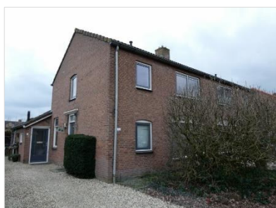
Figuur 2.16 Aanzicht en kopgevel van een van de woonblokken aan de Van Welderenstraat te Valburg.
