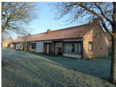
Figuur 2.7 Voorzijde van de woningen aan de Hessenbergstraat te Zetten.
