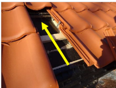
Figuur 6.7 Voorbeeld plaatsen vogelschroot bij derde rij dakpannen.
