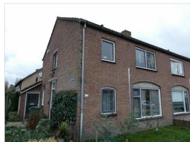
Figuur 2.15 Aanzicht en kopgevel van een van de woonblokken aan de Van Welderenstraat te Valburg.
